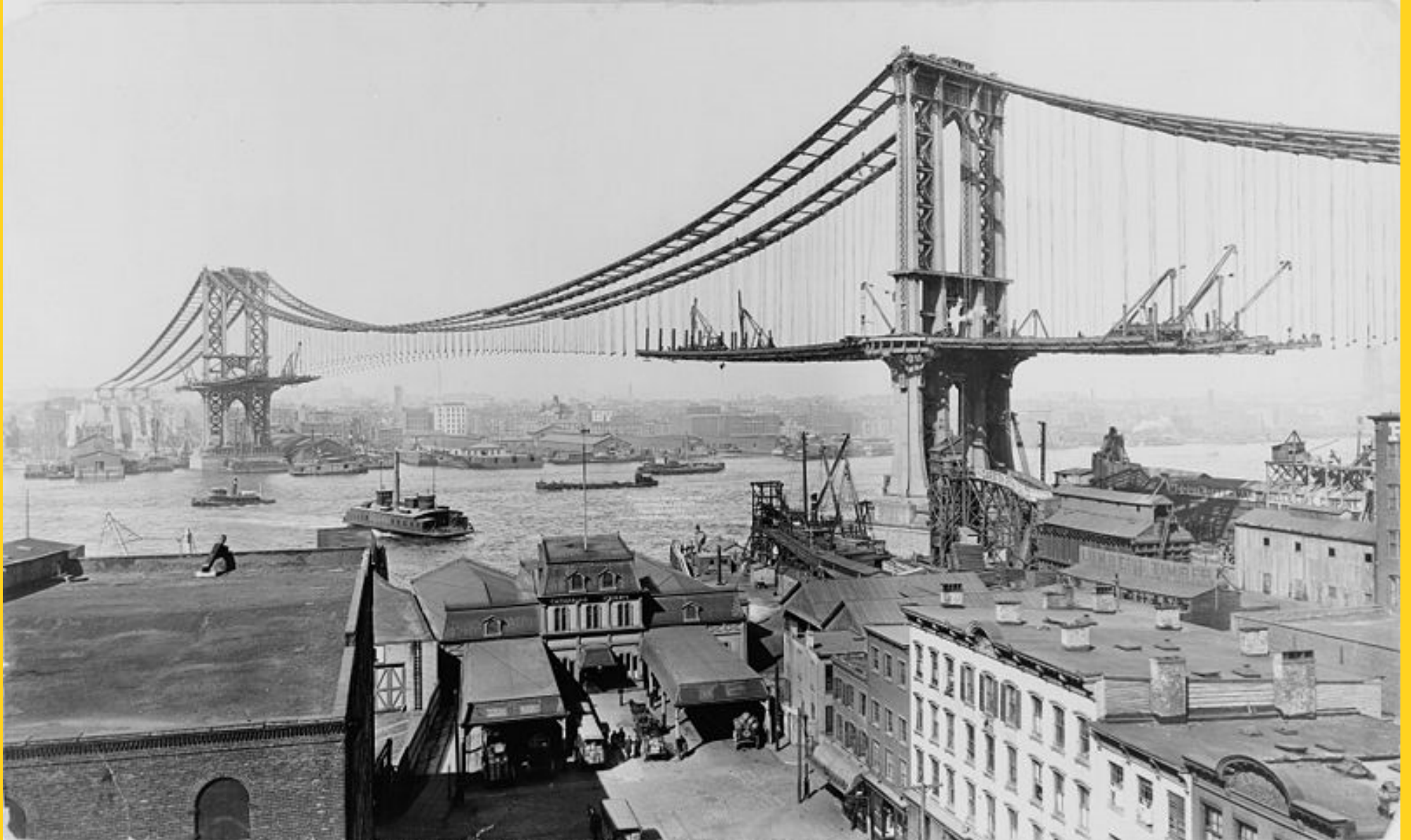
La construction du pont de Manhattan (New York) sera complètement terminée en 1912.
